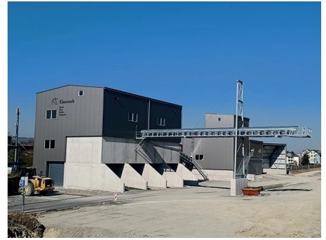
Aushubwaschanlage Kieswerk Ballwil
