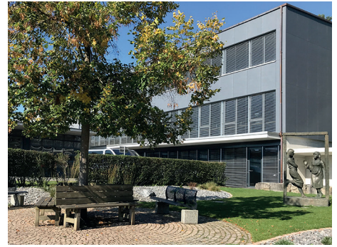
Neuer Anbau der Schulanlage
