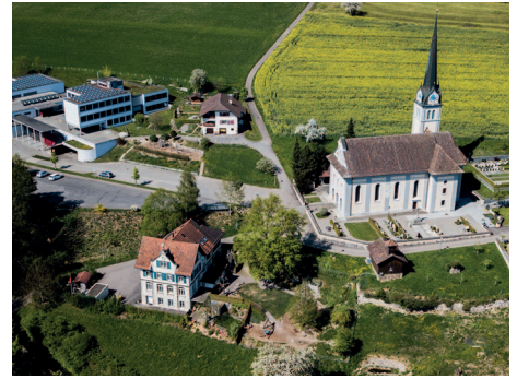
Ansicht auf Pfarrkirche Eich mit Schulanlagen
