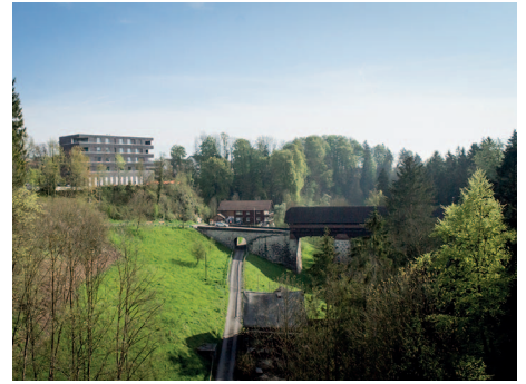
Alte Holzbrücke in Rothenburg
