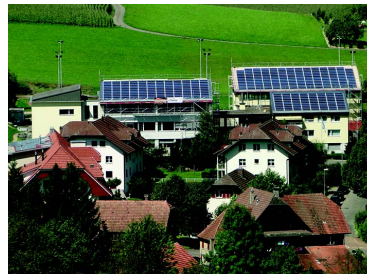
Aufbau einer Photovoltaikanlage auf die Schulhausdächer
