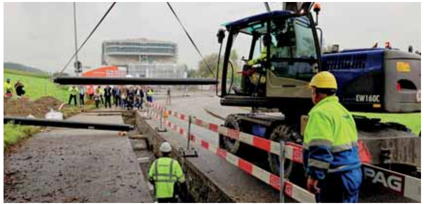
Bild: ewl energie wasser luzern
