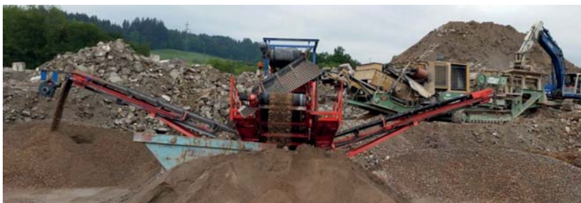
Mischabbruch wird zerkleinert und gesiebt.
