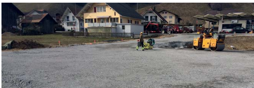
Einbau von Elektro-Ofen-Schlacke als Fundationsschicht beim Bau einer neuen Verkehrs- und Parkfläche in Escholzmatt.
