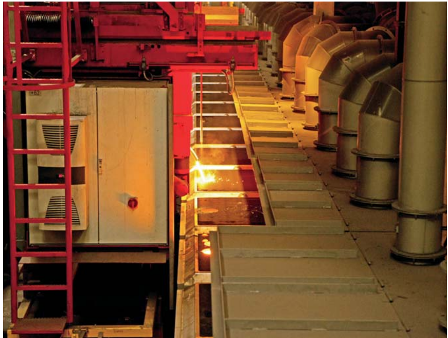
Blick in die Produktionshalle der vonRoll casting Gruppe in Emmenbrücke
