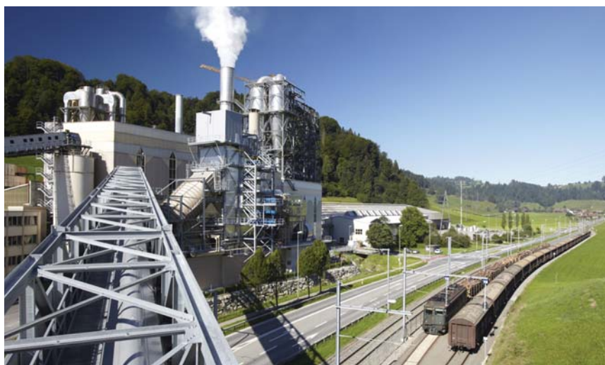
Eine der vier Altholz-Verwertungsanlagen im Kanton Luzern: Biomassen-Energiezentrale der Firma Kronospan AG in Menznau. Foto: zvg
