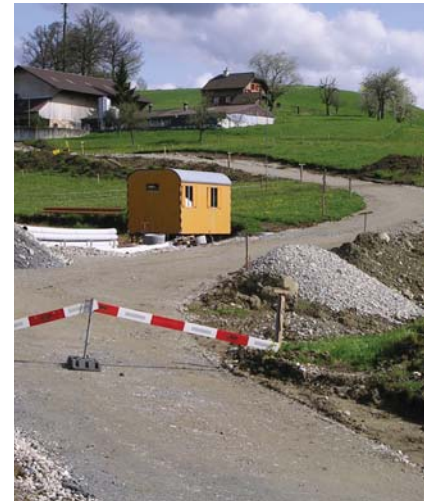
Strassenneubau im Luzerner Hinterland.
