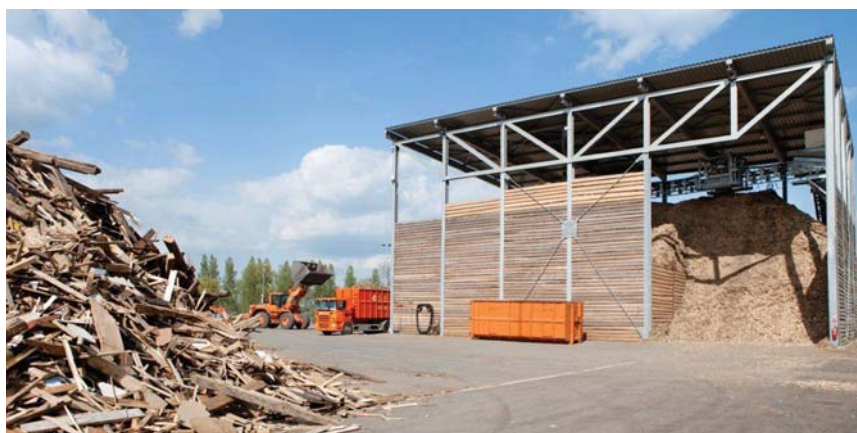
Korrekte Zwischenlagerung von Altholz auf einem Platz mit wasserdichtem Belag, Randabschluss, Entwässerung über Schlammsammler in die Kanalisation und Überdachung des geschredderten Altholzes.
