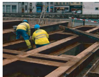
Arbeiten am Reusswehr in der Stadt Luzern.
