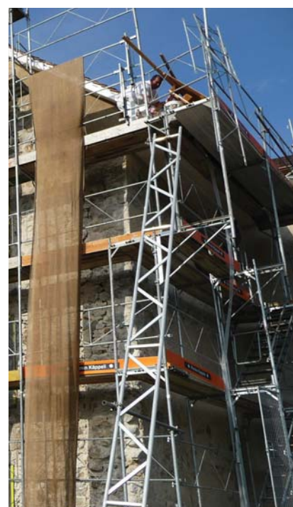
Baustelle in Hohenrain. Foto: Dienststelle Immobilien
