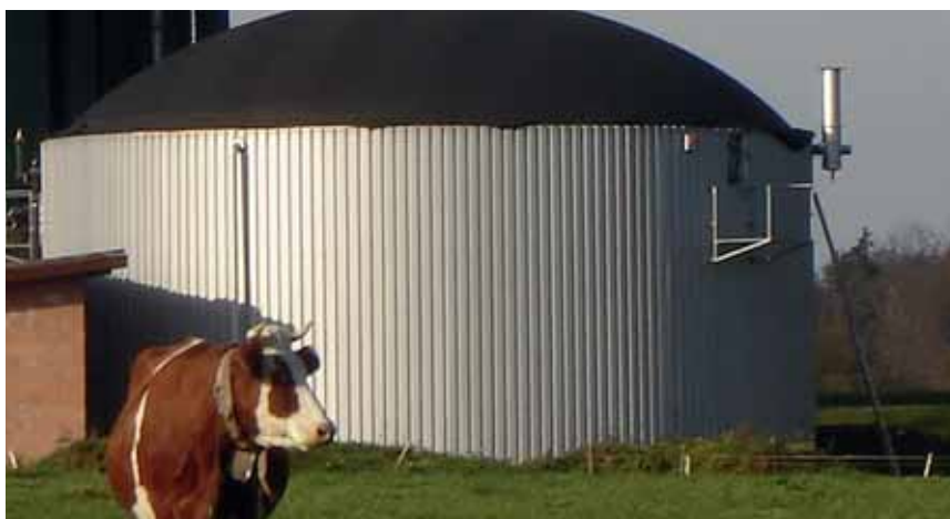
Die Funktionsweise der Biogaserzeugung wird gerne mit derjenigen des Kuhmagens verglichen. Sowohl im Kuhmagen als auch im Fermenter zersetzen Mikroorganismen unter Luftabschluss Biomasse und erzeugen Methangas.
