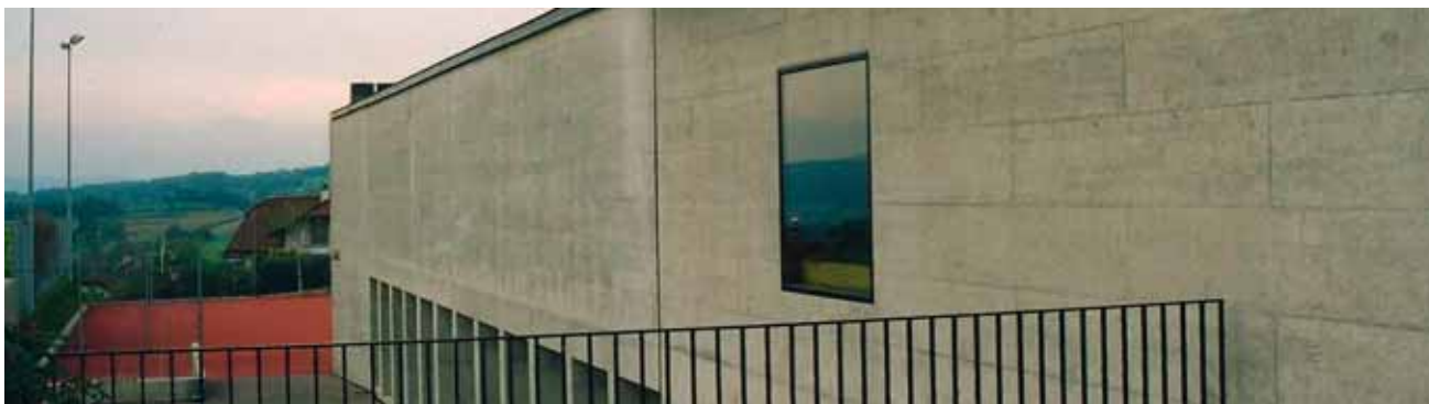
Turn- und Mehrzweckhalle Hohenrain.
