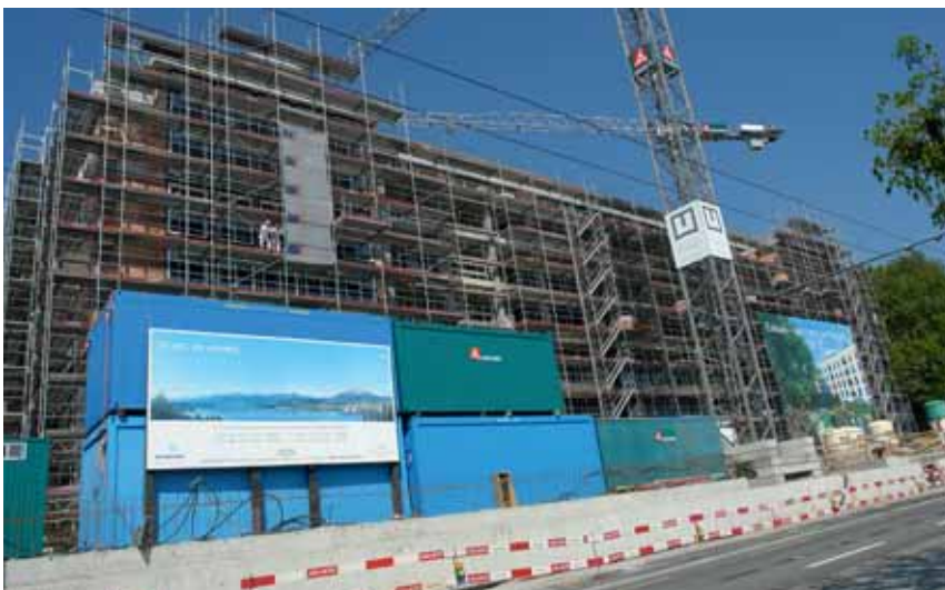
Baustelle in der Stadt Luzern in der Nähe des Sees
