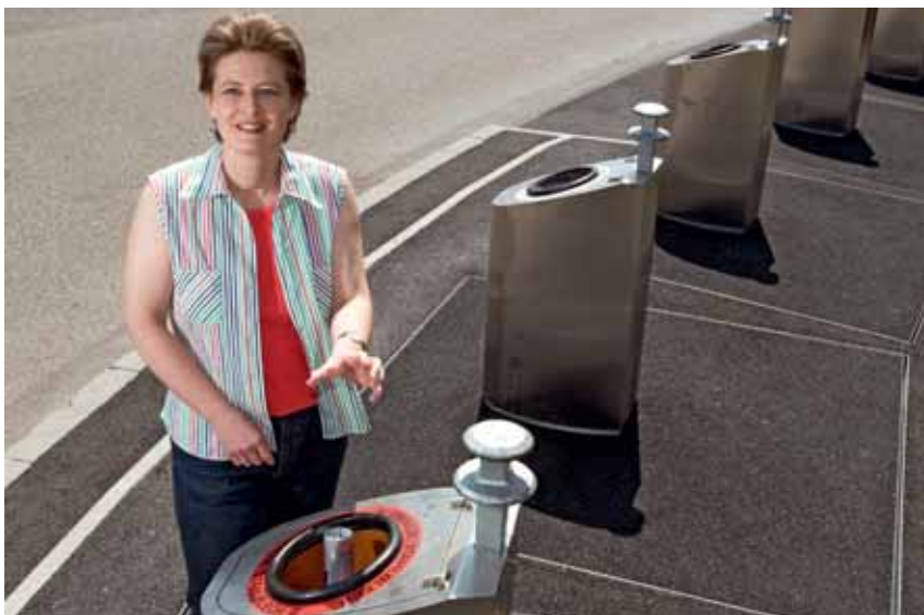
Die neuen Unterflur-Container der Sammelstelle beim Einkaufszentrum Emmen: Weil überirdisch nur die schmalen Einwurfröhren für Separatabfälle sichtbar sind, wird der Platz weniger mit Unrat überstellt (im Bild: Susanne Schwegler, Leiterin Umweltsammelstelle Emmen).
