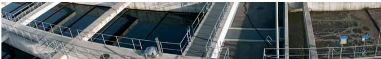
An der Erneuerung der Abwasserreinigungsanlage Region Luzern in Emmen (im Bild: Biologiebecken) war unter anderem auch das Bauunternehmen Anliker AG beteiligt. Die Bauzeit dauerte sechs Jahre lang.
