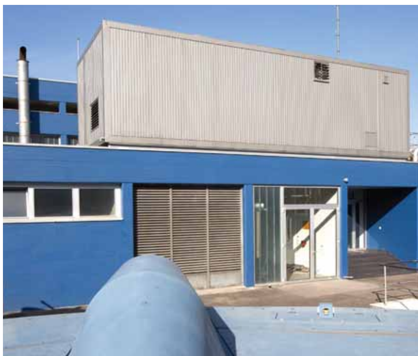
Die ARA Region Luzern produziert Klär- beziehungsweise Biogas und erzeugt mit einem Teil davon Strom. Der Rest wird aufbereitet und ins Erdgasnetz eingespeist. Foto: KVA Luzern
