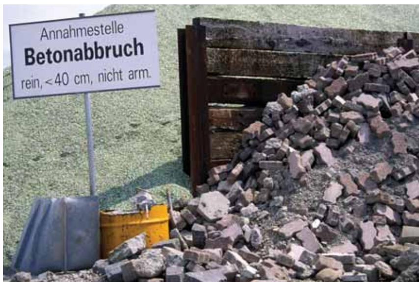
Mineralische Abfälle wie Betonabbruch oder Asphaltbeläge bilden die wichtigste Fraktion der getrennt gesammelten Abfälle auf Baustellen. Foto: Fotoagentur AURA
