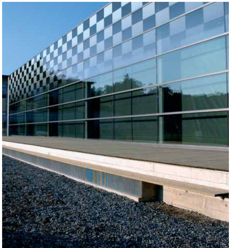
Mit der Sporthalle Hofmatt hat die Gemeinde Meggen seit Herbst 2005 eine moderne Dreifachturnhalle.
