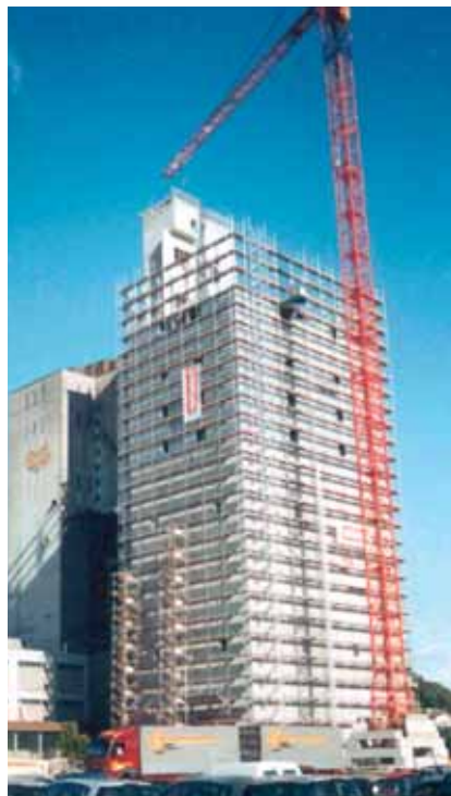
Baustelle in Nebikon
