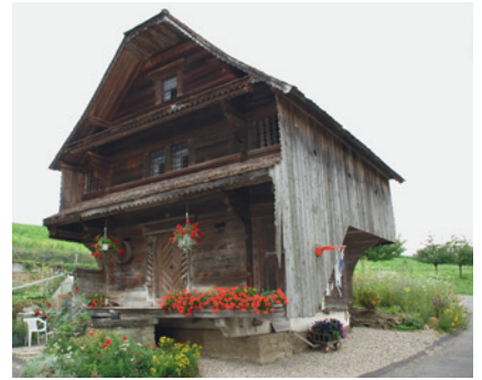
Spycher Chneubüelerhof im Ortsteil Eppenwil, erbaut 1727
