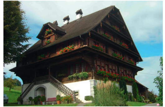
Wohnhaus der Hofgruppe Hinterspichten
