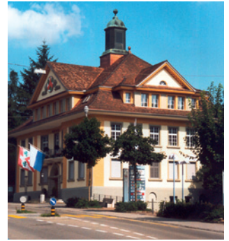
Rathaus, erbaut 1913/14 von den Architekten Möri und Krebs
