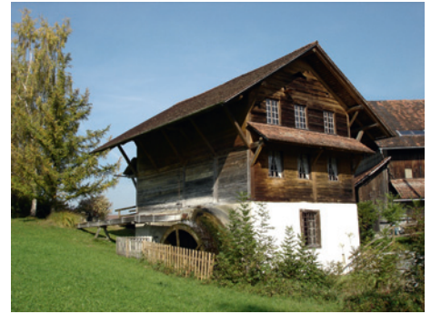
Schlossmühle aus dem 17. Jahrhundert (1979 renoviert)
